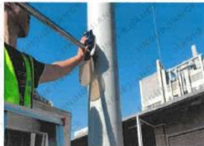
清洗废气处理后监测口 (气-07)
