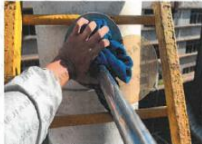
激光焊接废气处理后监测口 (气-05)
