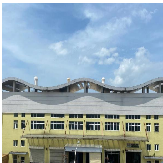
项目废气排放口
