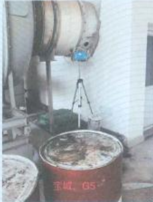
3#废气有组织排放处理前检测口 G5
