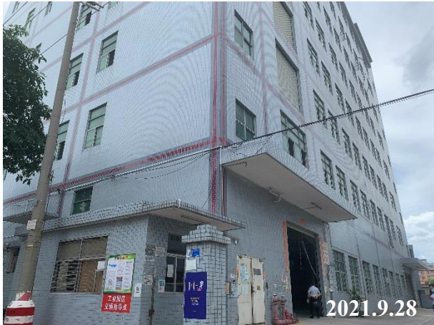
项目所在位置厂房外观
