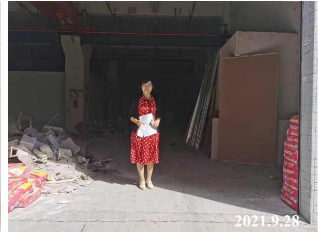
工程师现场勘察图片①
