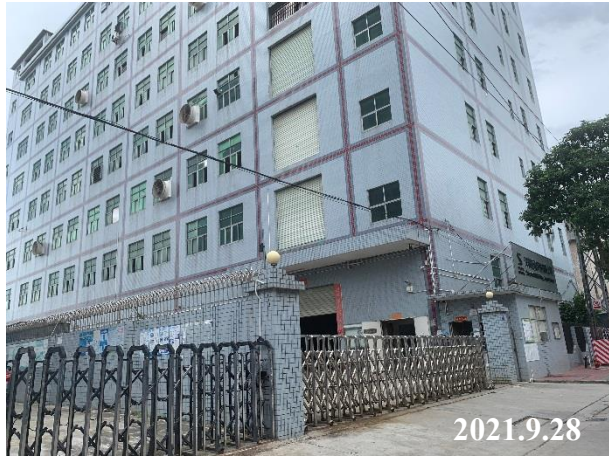
项目北面工业厂房
