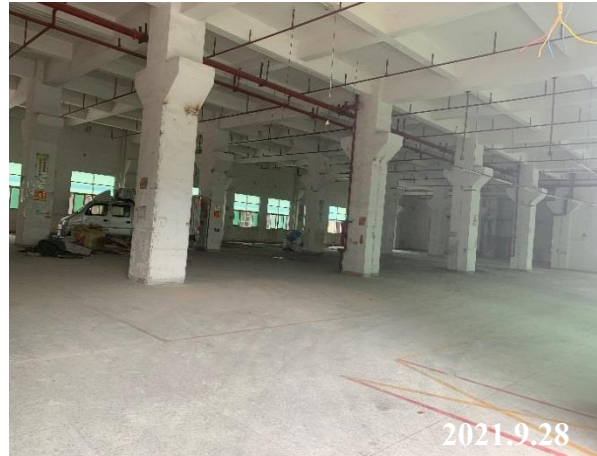
项目车间现状
