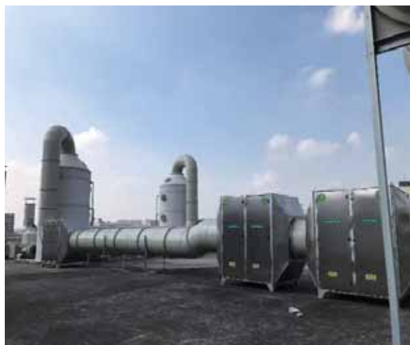
捏合废气处理设施：“两级喷淋塔+干式过滤器+二级活性炭装置”
