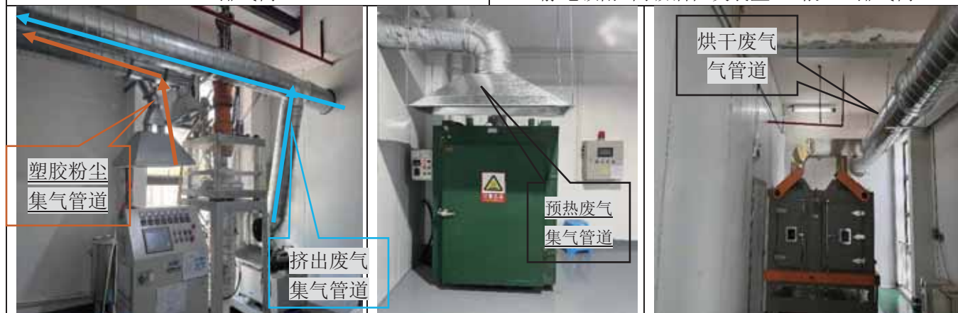
塑胶粉尘废气处理设施：“脉冲袋式除尘器”+1根25m 排气筒
