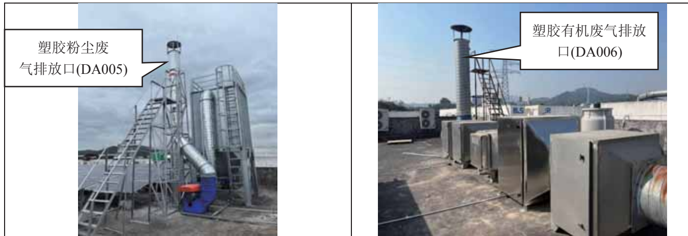
塑胶粉尘废气处理设施：“脉冲袋式除尘器”+1根25m 排气筒
