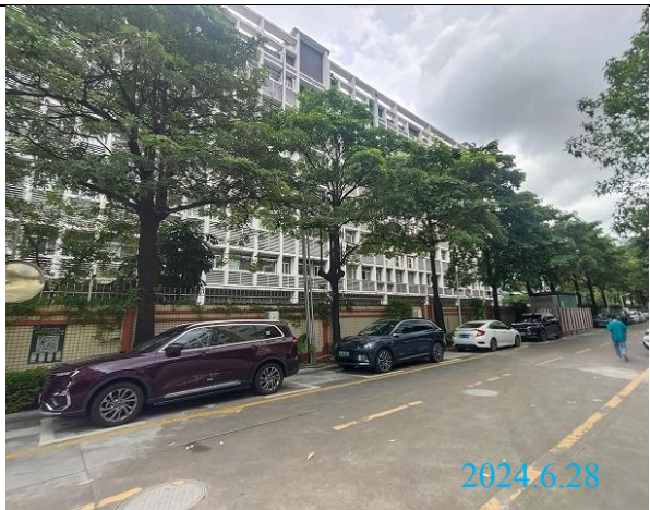
项目西北面——职工宿舍
