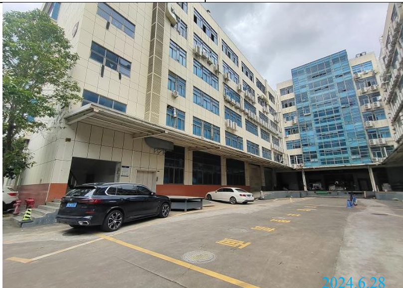
项目所在位置——1楼、3楼、4楼之一
