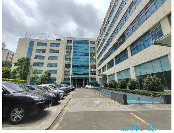
项目东南面——高新科技园综合楼
