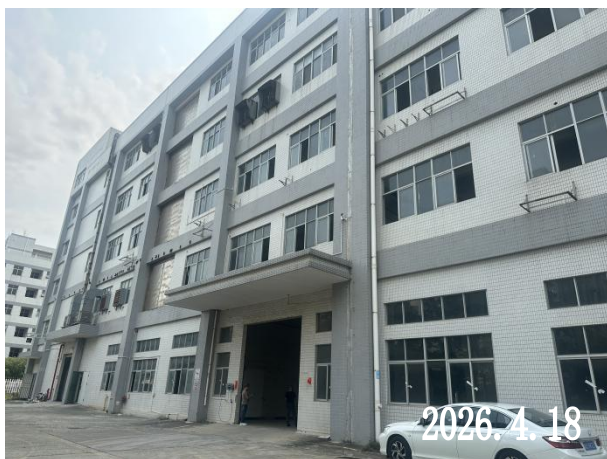
项目所在厂房建筑物外观
