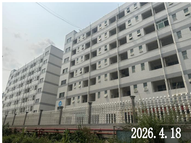
项目北面工业宿舍
