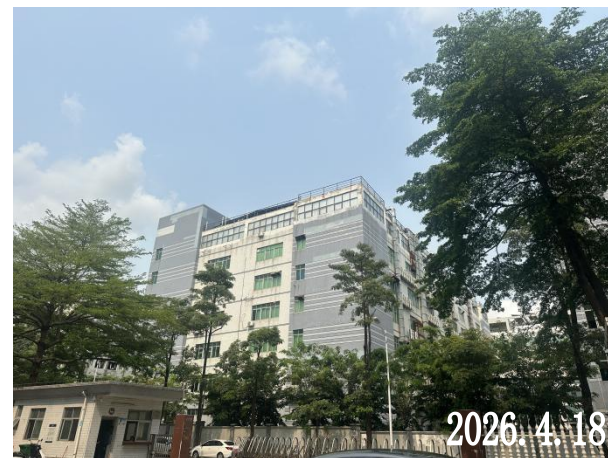
项目东面工业厂房
